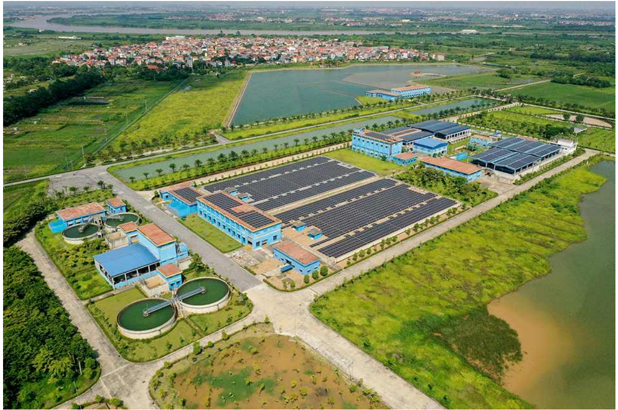
[사진] 2. 베트남 하노이에 위치한 송동정수장 전경. 하루 30만 m ³의 수돗물 생산능력을 갖추고 약 300만 명의 하노이 동부지역 주민에게 깨끗한 물을 공급하는 주요 시설로, 한국수자원공사의 AI 기술을 도입해 약품주입 자동제어와 운영 효율화를 추진할 예정이다.
