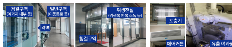
위생 전실 설치
