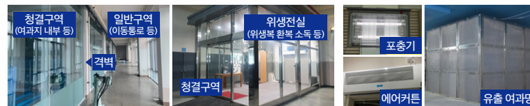
위생 전실 설치
