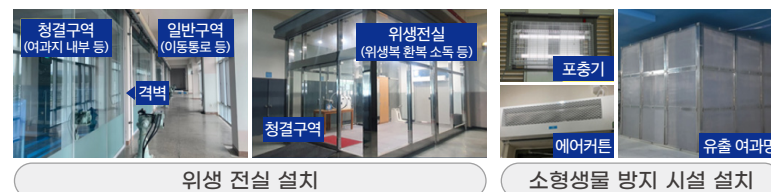
위생 전실 설치
