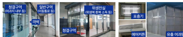
위생 전실 설치
